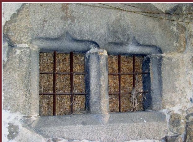
▼ Figure 14 | baie géminée de Chatelville
