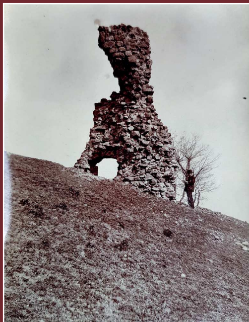
▼ Figure 22 | bloc de maçonnerie (tour ?) ; Abbé Begonnet, 1907, SHA de la Diana
