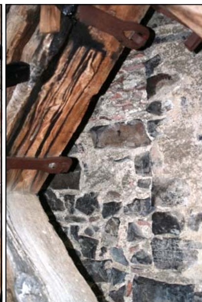
Photo 44 : ouverture bouchée sur la façade sud du clocher
