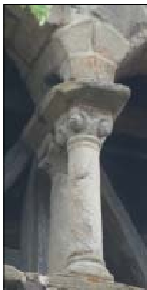
Photo 29 : retombée de l'arc central sur deux colonnettes à chapiteaux sculptés
