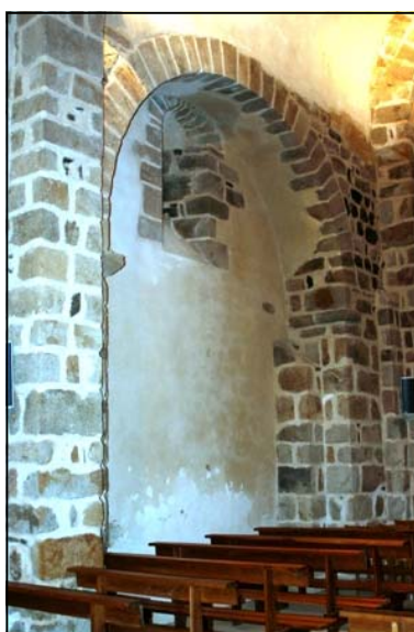
Photo 34 : mur nord de la seconde travée de la nef
