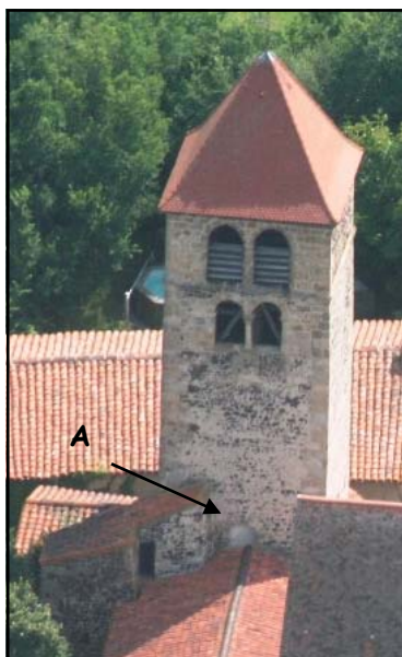
Photo 28 : vue aérienne de la façade ouest du clocher
