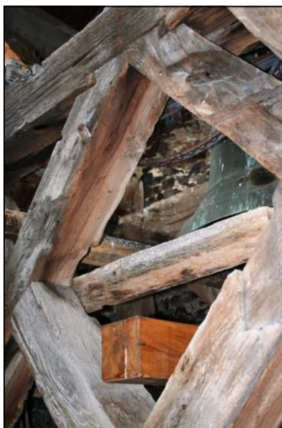
Photo 43 : poutres permettant l'accrochage des cloches
