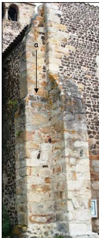
Photo 8 : contrefort de la façade et contrefort de la nef
