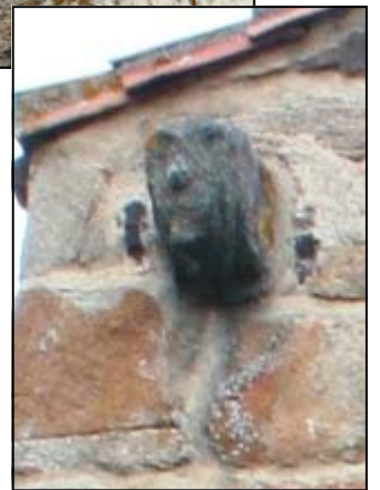
Photo 19 : façade sud du transept sud, remplis d'une tête sculptée
