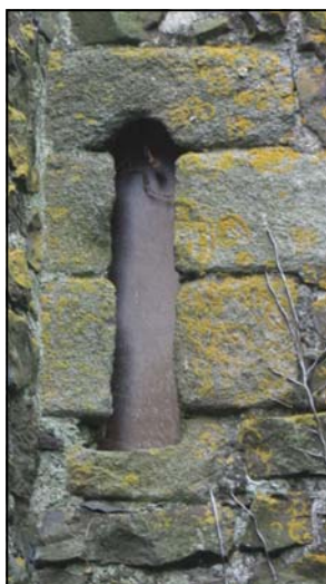
Photo 11 : fenêtre meurtrière de la seconde travée au nord
