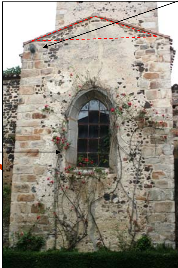
Photo 20 : façade sud du transept sud
