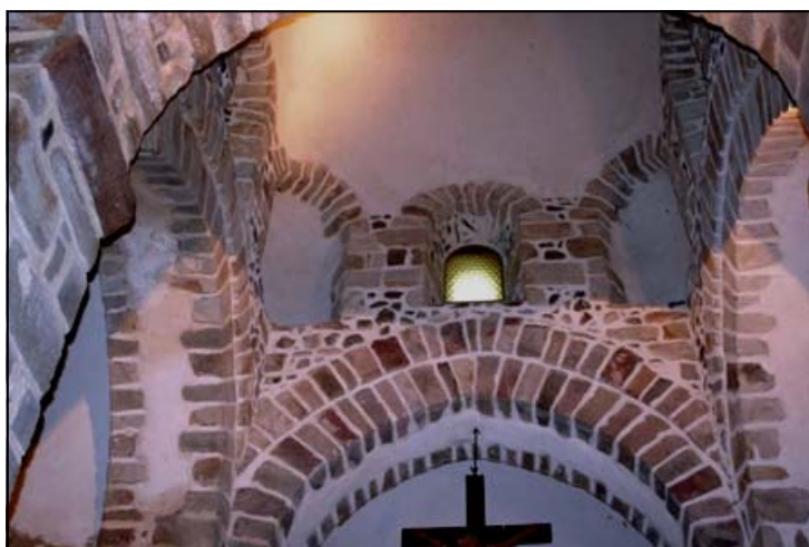
Photo 38 : la coupole sur trompes
