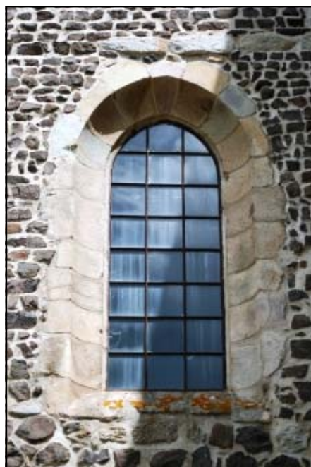
Photo 5 : fenêtre de la façade de l'église de Chalain d'Uzore
