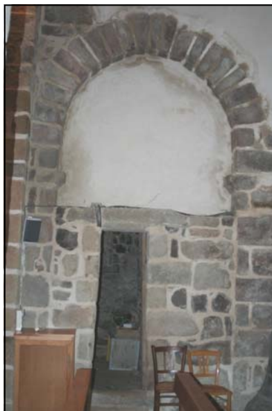
Photo 41 : mur ouest du bras du transept sud, accès à la cour
