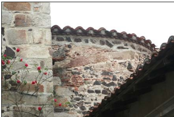
Photo 27 : haut du mur et toiture de l'absidiole sud
