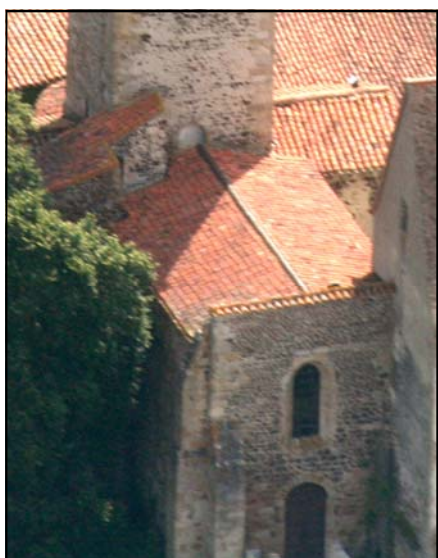
Photo 6 : vue aérienne de la façade, en légère contre-plongée
