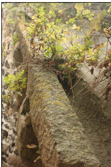
Photo 26 : chéneau en pierre entre l'abside et l'absidiole sud
