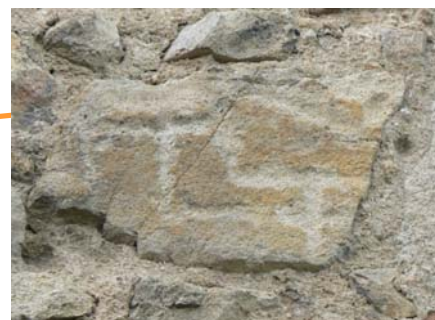
Photo 17 : bâtiment E, façade est
