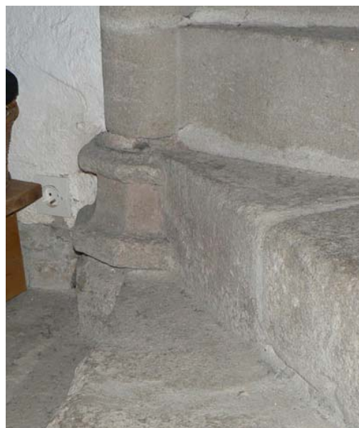
Photo 15 : escalier à vis, base prismatique
