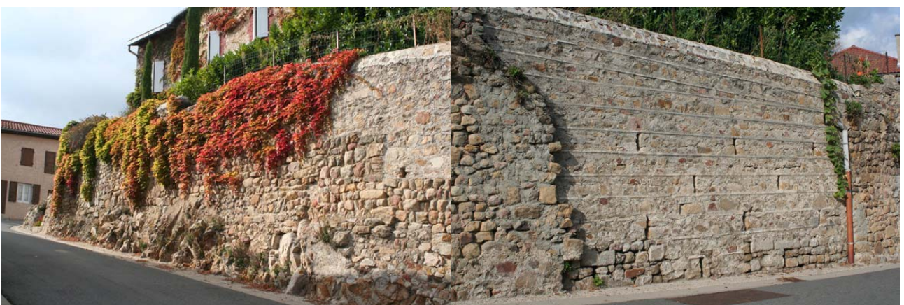
3. Mur de soutènement de l'emprise prieurale à l'ouest
