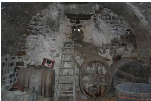
Photo 18 : salle 2 : voûte et petite baie
