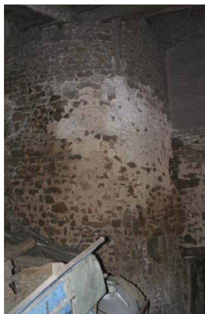
Photo 19 : pressoir dans la salle 1
