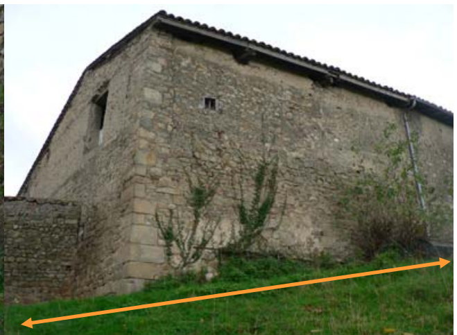
2. Dépendance construite sur la pente naturelle
