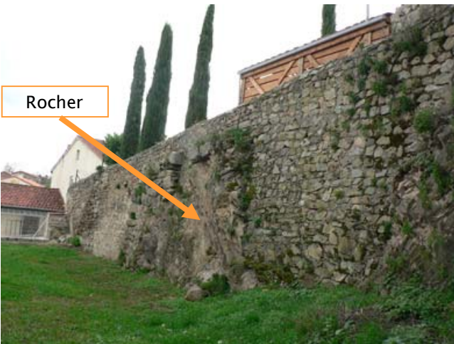
1. Mur de soutènement des bâtiments conventuels
