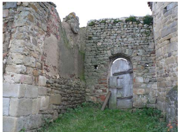
Annexe 8 : dépendances vues hors les murs
