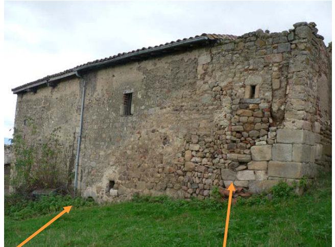
Bâtiments D et E
