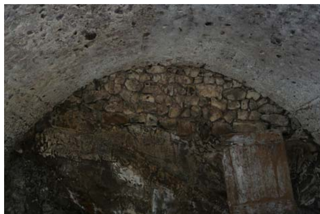
Photo 21 : cave, mur ouest reposant sur le rocher
