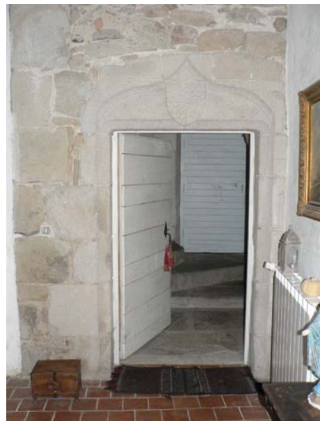
Photo 13 : porte P1 de la tour d'escalier
