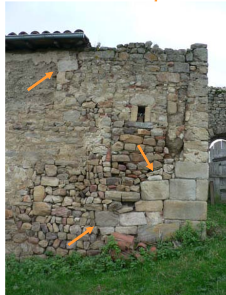
Modifications du bâtiment E
