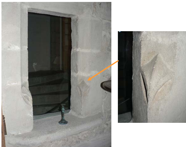
Photo 14 : fenêtre au-dessus de P1
