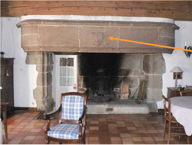
Photo 10 : cheminée du rez-de-chaussée
