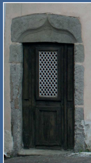
Figure 22-7 | Rue de la République ▲
