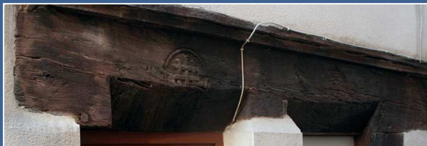
▲ Figure 22-3 | Rue de la République
