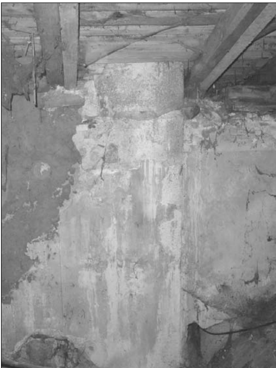
Photo 2, ci-dessus : chaînage d'angle du clocher dans les combles
