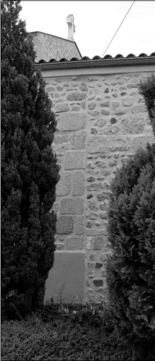
Photo 24 : chaînage dans le mur extérieur de la sacristie
