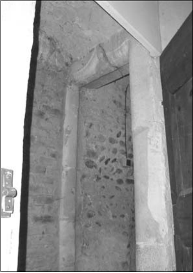
Photo 11 : porte d'accès au clocher
