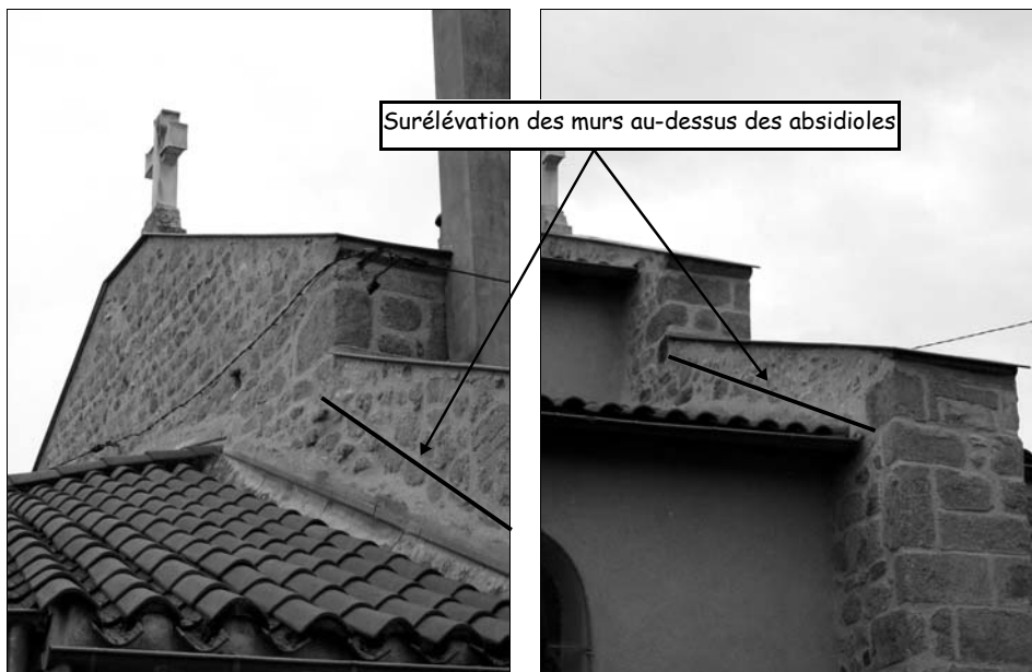
Photos 25 et 26 : mur pignon et modification
