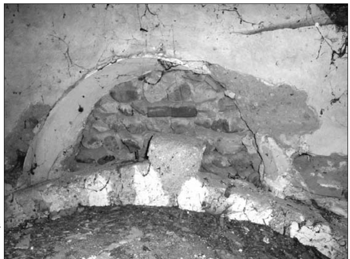
Photo 3, ci-contre : oculus bouché dans le mur de façade
