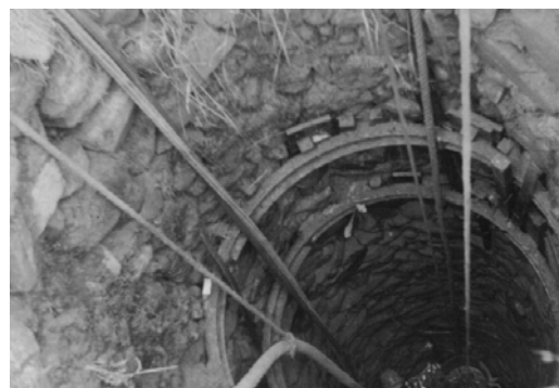
Photo 4 : fouilles du puits, avec son cerclage métallique de sécurité Archives privées
