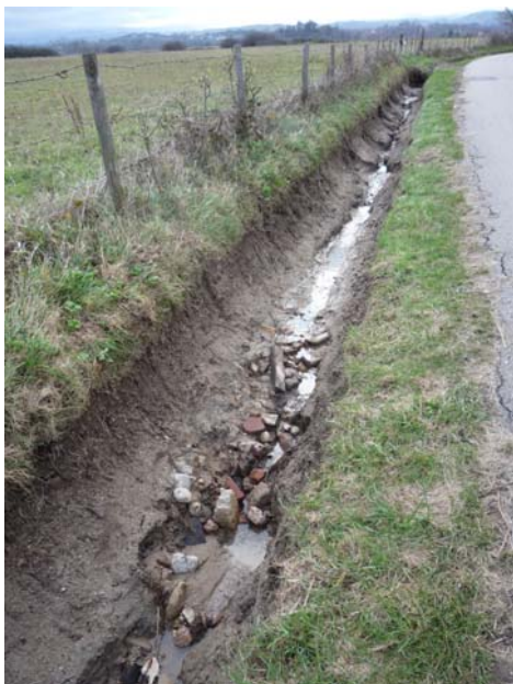
Photo 10 : le curage du fossé le long de la route conduisant au lieu-dit les Alliés ,
