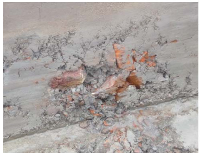
Photo 7 : la fosse sur la paroi est et sur le fond de la tranchée de drainage
